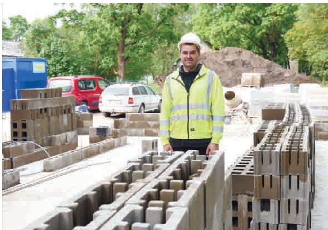
Пристройка возводится рядом с действующим зданием.
