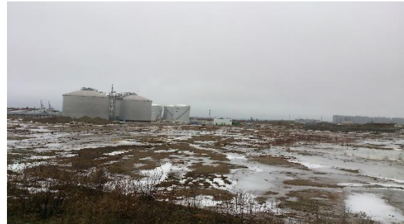
Foto 2. Vaade Kesk tn 2c ammoniaagi sadama-ala läänepiirilt. Esiplaanil vasakule jääb Kesk tn 2n kinnistu, mis on uute ammoniaagimahutite võimalikuks alternatiivseks asukohaks.
