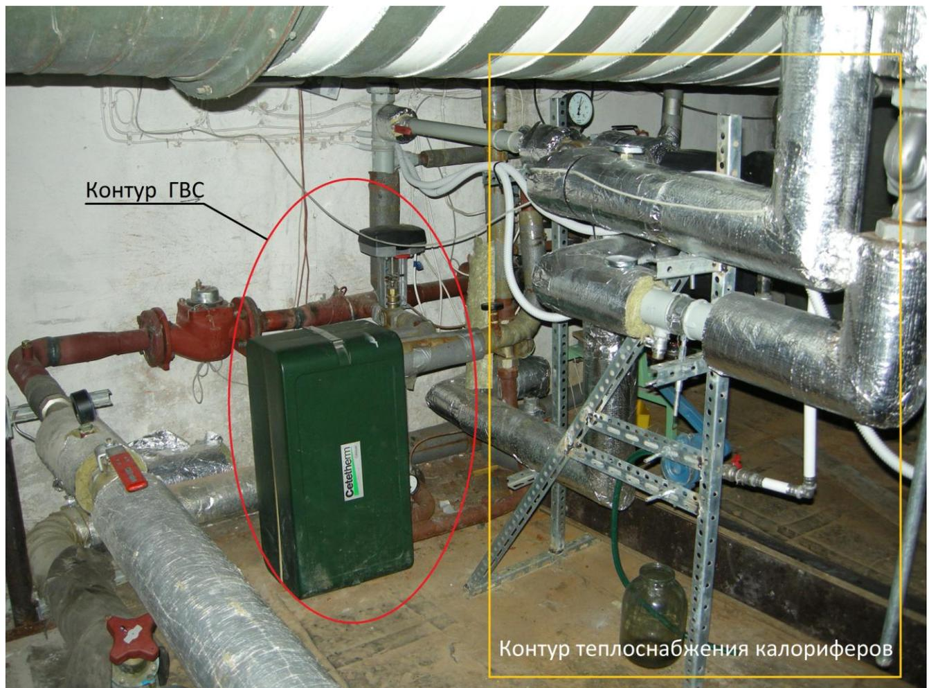
2. Установленные в разное время контуры теплового узла размещены крайне неудачно для обслуживания, а элементы старого теплового узла (использовавшегося до 1996 года) вносят путаницу в гидравлическую схему.
