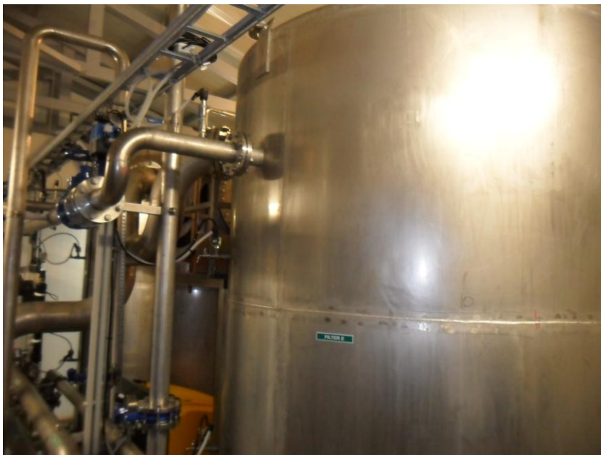
Joonis 6-19 Mikrorajooni VTJ gravitatsioonilise filtri paagid
