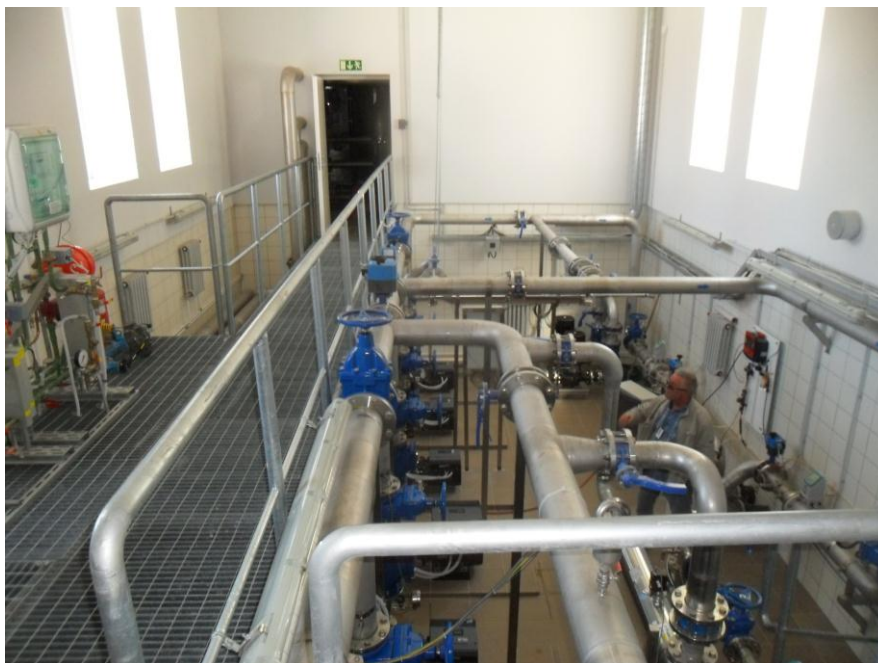
Joonis 6-16 Mikrorajooni pumpla II astme pumpla
