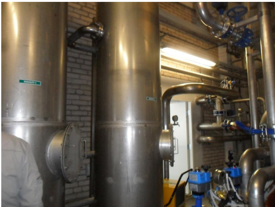
Joonis 6-18 Mikrorajooni VTJ kontaktmahutid
