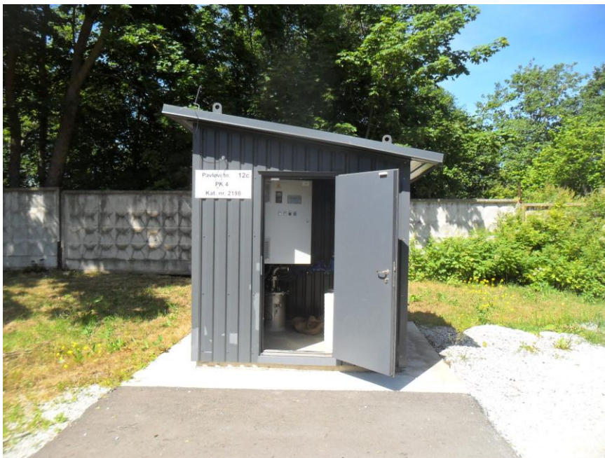
Joonis 6-1 Keskpumpla territooriumil paikneva puurkaevpumpla nr 4 välisvaade
