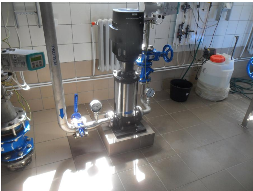
Joonis 6-13 Keskpumpla II astme pumpla sisevaade (pesupump)
