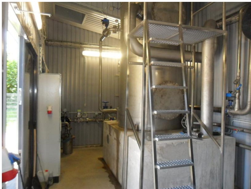
Joonis 6-6 Pk-8 rauaeraldusfilter
