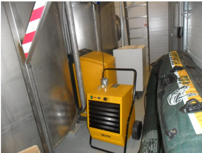
Joonis 6-14 filtrid ja õhukuivati
