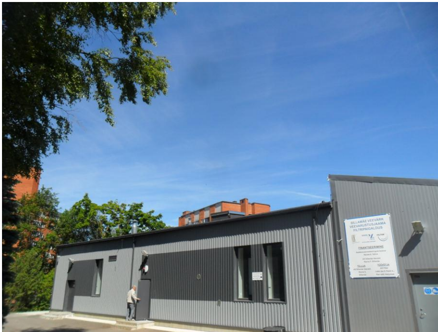
Joonis 6-15 Mikrorajooni pumpla ja VTJ hoone välisilme
