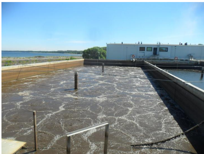
Joonis 6-27 Bioloogiline puhastus, SBR-mahuti
