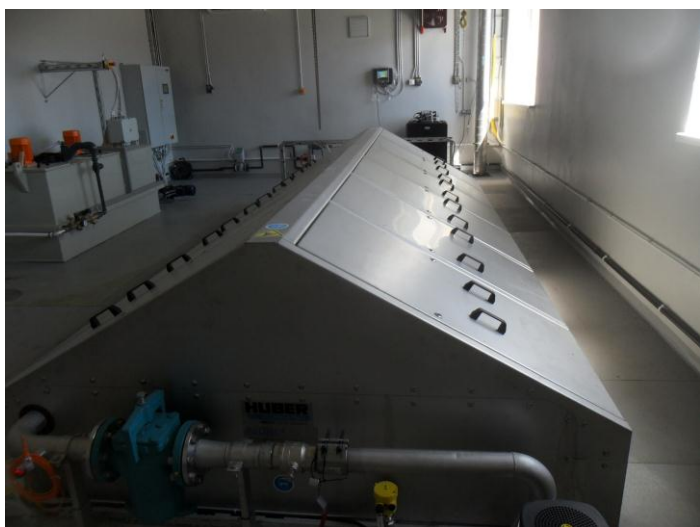
Joonis 6-28 Järelfiltratsioonisüsteem
