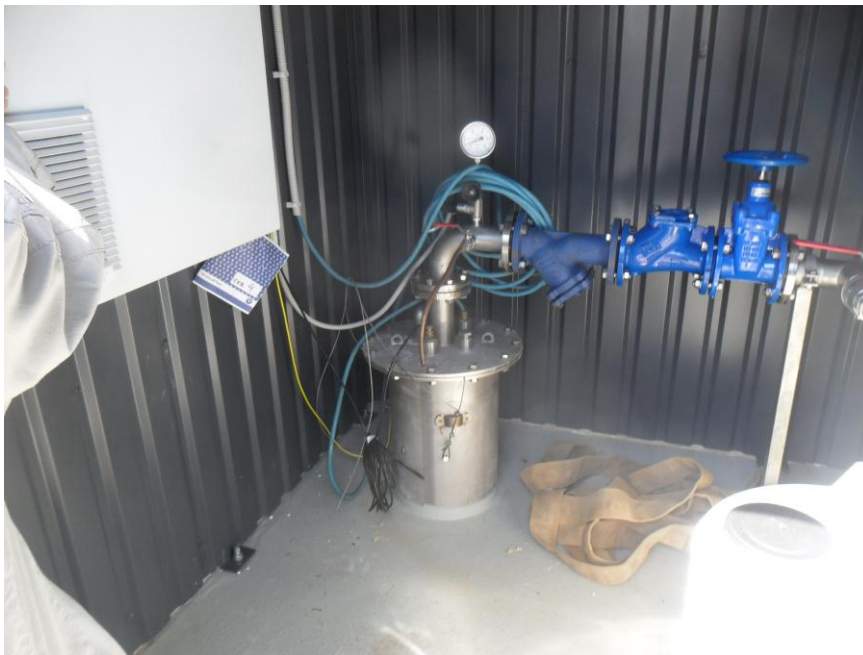
Joonis 6-2 Puurkaevpumpla nr 4 sisevaade (puurkaevu päis)
