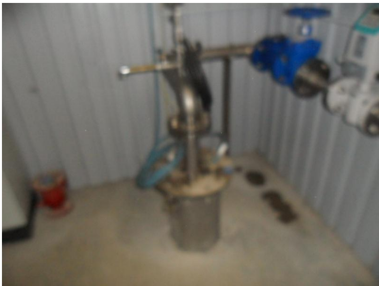
Joonis 6-4 Puurkaevpumpla nr 8 sisevaade (puurkaevu päis)
