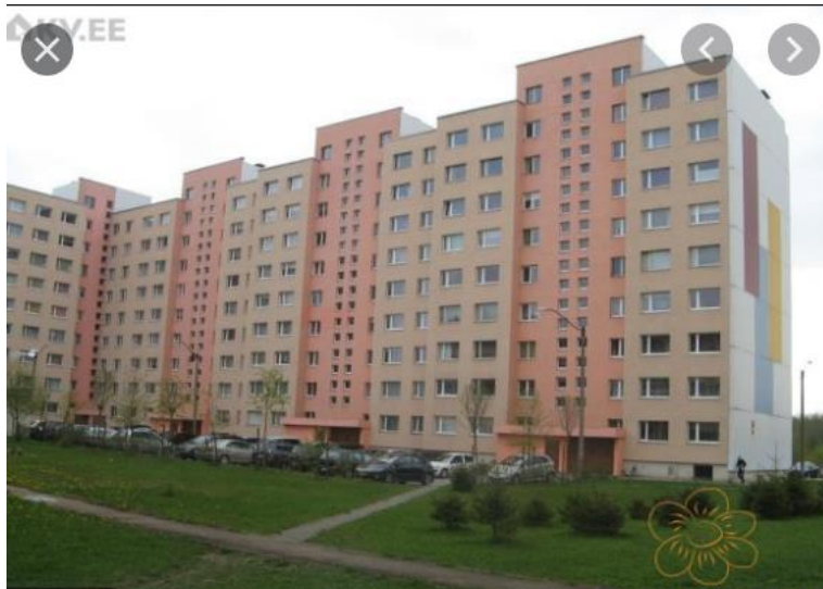
9-korruseline paneelmaja 121-02E (foto kv.ee)
